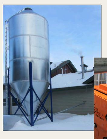
20 Ton Pellet Silo Automatic Auger Feed
